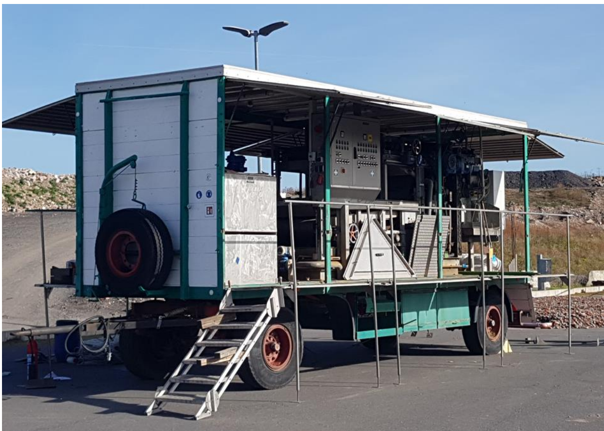
Bild 2: Siebbandfilterpresse im ausgeklappten Zustand (Foto 2023)
